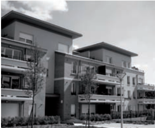
France Habitation 102 logements - Deuil la Barre
