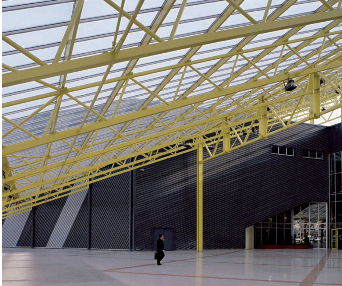
Bonneuil sur Marne, France Centre commercial
