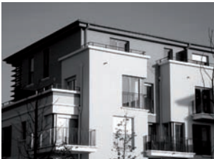
Groupe Gambetta 51 logements - Noisiel
