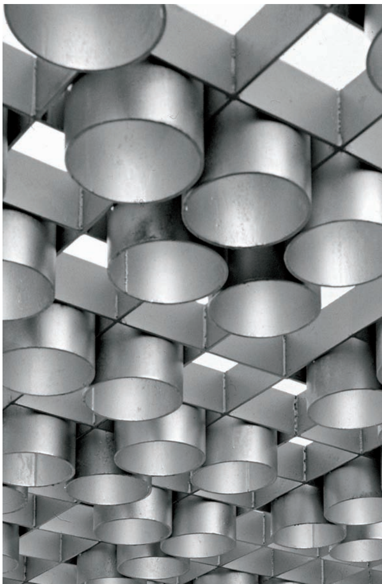
Abidjan, Côte d'Ivoire Villa, détail du plafond
