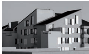
Pax & Progrès / UFIC - SIVEGI 412 logements - Melun sénart
