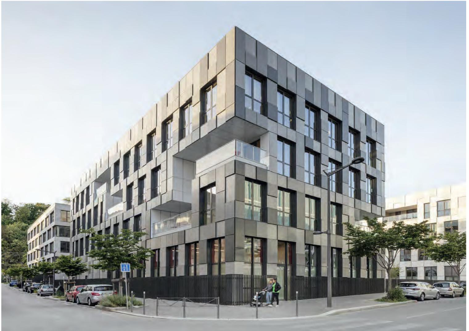
**Concevoir la vitrine architecturale d'une entreprise japonaise** Evoquant l'univers technico-ludique de Bandai-Namco, l'enveloppe des deux ailes est une composition pixellisée constituée de cassettes d'aluminium laqué de taille et de profondeur différentes. Les décalages en plan sont mis en scène par les jeux d'ombre et de lumière qui sculptent le nu des parois. Ces variations sont accentuées par les percements ponctuels des loggias.
